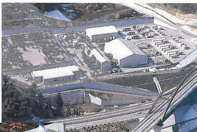
電力変換変電所 Power conversion substation
